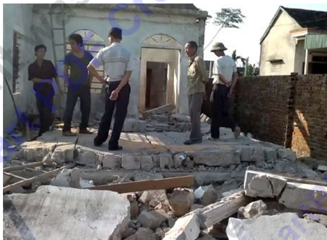
Hiện trường vụ sập tường nhà làm 2 người chết, 3 người bị thương nặng (ảnh: Xuân Bắc)
