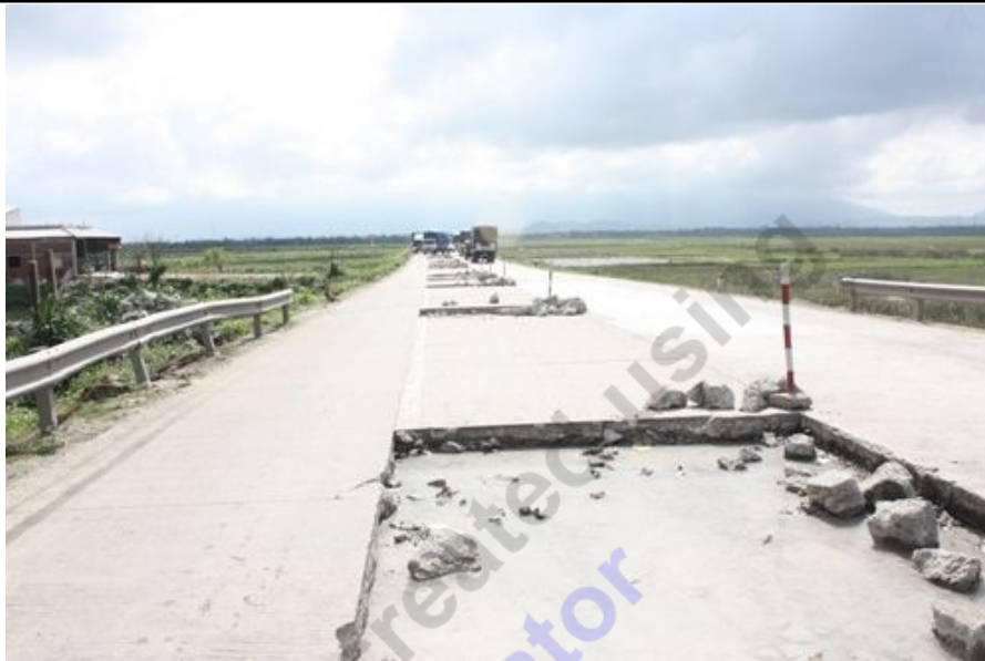
Đoạn đường được sửa chữa ở giữa
