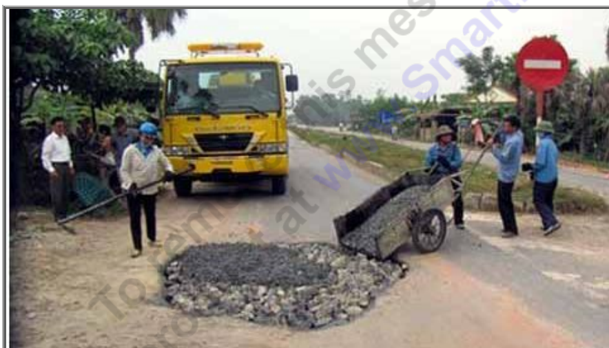
Một ổ voi đang được lấp đá. Sự xuống cấp liên tục, nghiêm trọng trên tuyến đường này đã khiến dư luận nghi vấn có sai phạm trong quá trình thiết kế, giám sát, thi công. (Ảnh: DT)
