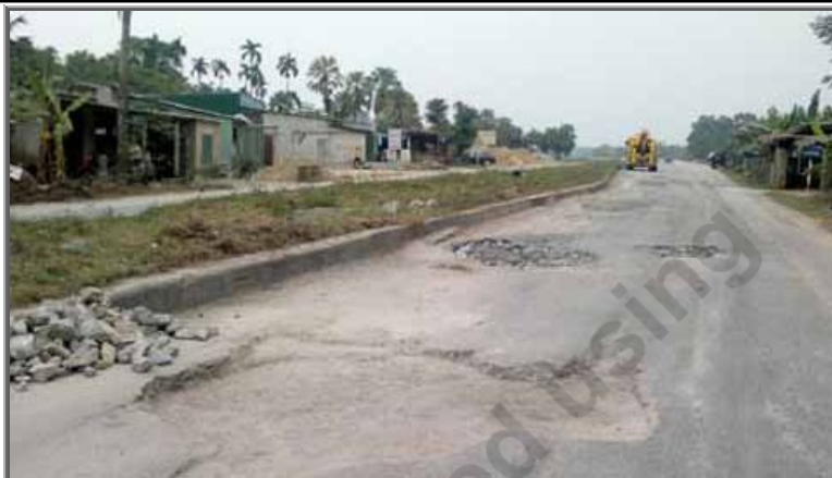
Những ổ voi đang được vá vúi tạm thời. “Căn bệnh” thực sự của tuyến đường này sẽ có sau khi Viện Khoa học & Công nghệ - Bộ GTVT có kết quả kiểm tra. (Ảnh: DT)
