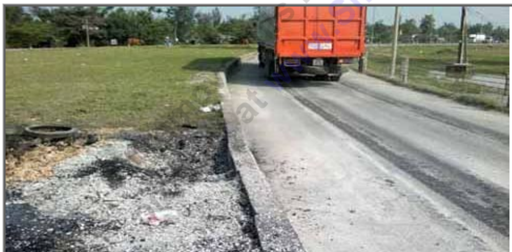
Nhiều hạng mục được thiết kế rất “vô duyên” trên suốt tuyến đường đã làm cho lòng đường bị thu hẹp dẫn tới nền đường bị dồn nén quá nhiều dẫn tới xuống cấp. (Ảnh: DT)
