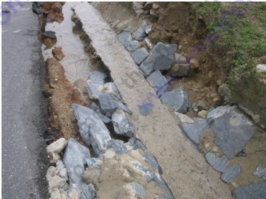
Hệ thống mương thoát nước không đảm bảo nên khi mưa to nước chảy lênh láng tràn trên mặt đường.
