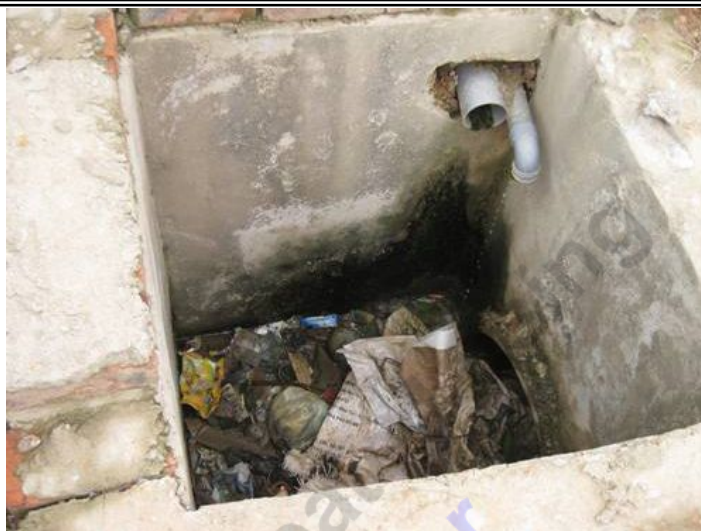
Hố ga trở thành hầm chứa rác thải
